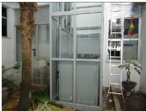
Foto 010 – Vista externa - piso inferior.
