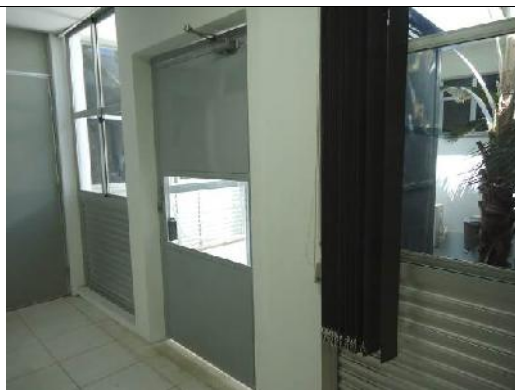
Foto 002 – Vista frontal – piso superior.
