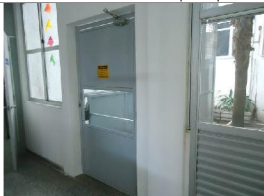
Foto 003 – Vista frontal - acesso térreo elevador.
