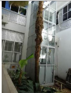
Foto 005 – Vista externa da plataforma de acessibilidade – jardim externo.
