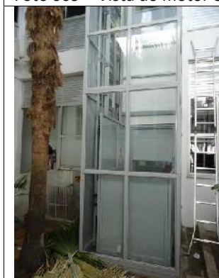
Foto 011 – Vista externa da estrutura metálica da plataforma de acessibilidade.
