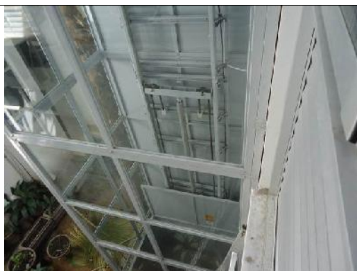
Foto 008 – Vista da estrutura do elevador.
