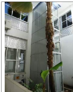
Foto 007 – Vista externa do elevador.
