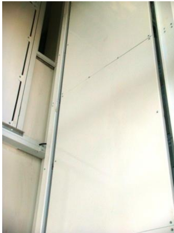
Coluna vista de dentro da caixa de corrida. A esquerda, acima, a porta do segundo pavimento.
